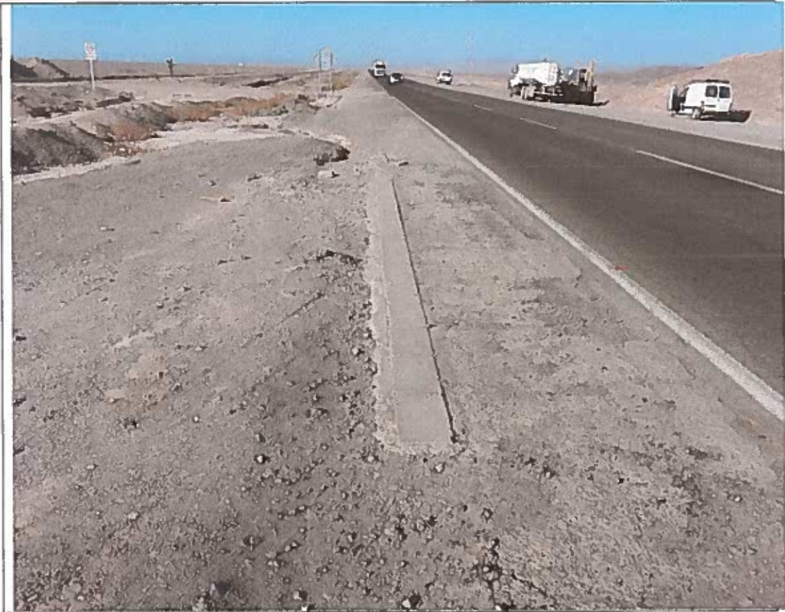
Vista de solera entre las Dm 72.560 y 72.570
